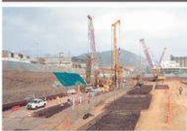
TRABAJOS EN MARCAO. El proyecto de obra ejecutará en el 2022. Para todo serían 100 metros.
